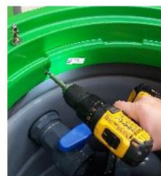
Helyezze fel a fedelet adaptert, és csavarozza be 4 csavarral.
