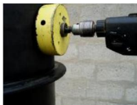
Fúrja ki a beömlő furatot egy megfelelő koronafűrővel
