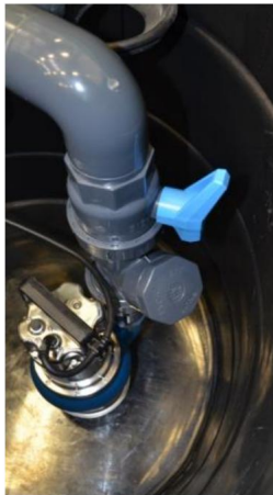
ELZÁRÓSZELEP NYITVA VAN
