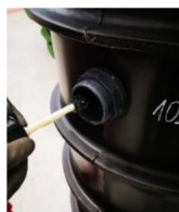
PVC-U ragasztó felvitele a csőre és az adapterre
