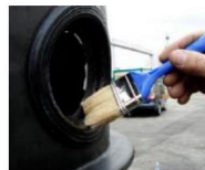
Helyezze be és kenje meg a bemeneti tömítést és a PVC csöveket
