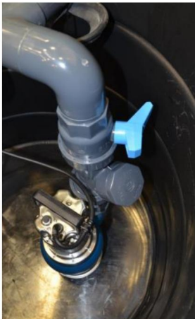
AZ ELZÁRÓSZELEP ZÁRVA VAN
