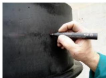
Jelölje meg a beömlőcső helyét (a PE tengely egyenes felülettel rendelkezik a beömléshez)
