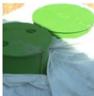
Amikor a szivattyútelepet a tereptől számított utolsó 20-30 cm-re elássák, fektetik le a geotextiliát.
