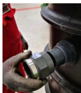
Vigyen fel ragasztót a PVC- U csőre, és ragassza össze az adapterrel.
