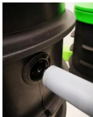
Nyomja be a PVC csövet DN50 a tömítésbe
