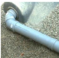
Óvatosan ássa be a szivattyútelepet a megfelelő, 4-16 mm szemcsméretű kavicsal.
