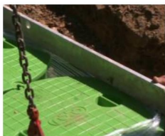
Győződjön meg arról, hogy a fedél és a terep megfelelően kiegyenlített
