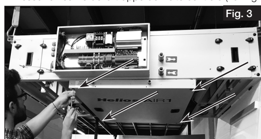
3. Faire glisser la trappe de visite en direction du boîtier électrique pour la retirer (voir fig. 4).
