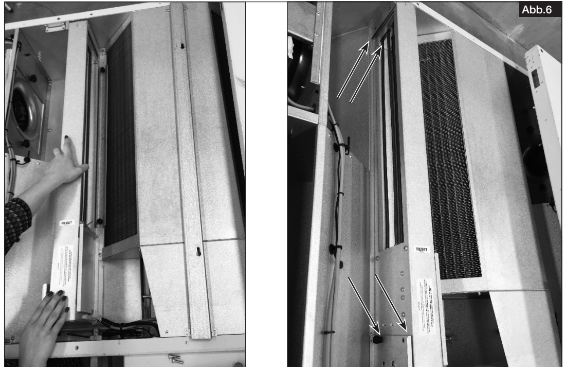
6. Elektrische Nachheizung über Stecker anschließen (s. Abb. 7).
