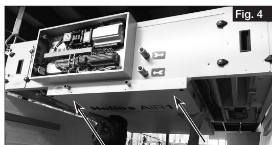
4. Le cas échéant, retirer la plaque de support (voir fig. 5).
