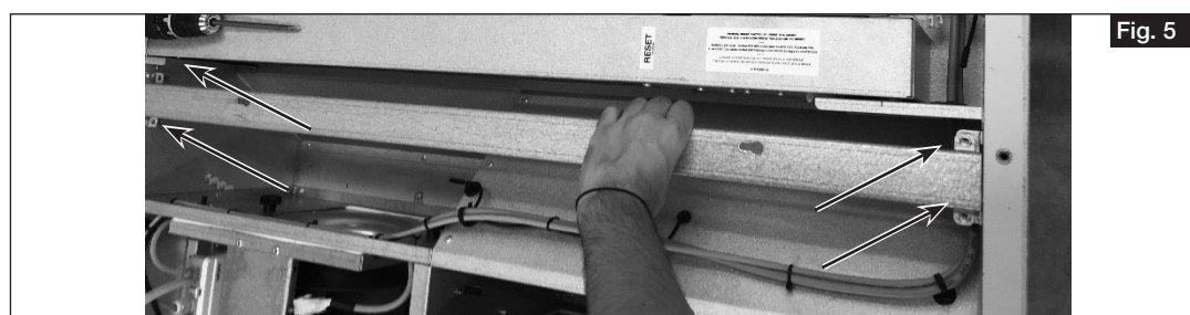
5. Installer la batterie électrique et monter les poignées étoiles (voir fig. 6).
