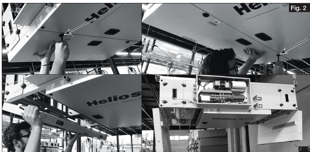
2. Desserrer les vis de la trappe de visite centrale (voir fig. 3).
