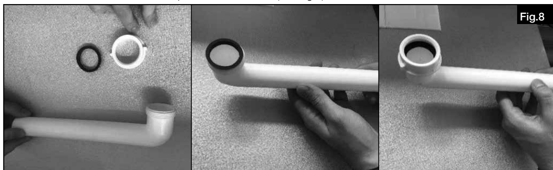
2. Fixer le coude du conduit sous le bac à condensat. S'assurer que la construction est étanche en faisant tourner le raccord (voir Fig.9).
